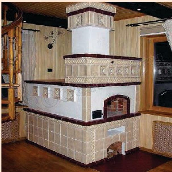
**ПЕРЕД НАЧАЛОМ ОТОПИТЕЛЬНОГО СЕЗОНА НУЖНО ПРОВЕРИТЬ ИСПРАВНОСТЬ ПЕЧИ И ДЫМОХОДА (УДАЛИТЬ САЖУ И ЕСЛИ НУЖНО ОТРЕМОНТИРОВАТЬ, ЗАМАЗАТЬ ТРЕЩИНЫ, ПОБЕЛИТЬ И ОТРЕМОНТИРОВАТЬ ТРУБУ НА ЧЕРДАК И ВЫШЕ КРОВЛИ)**
